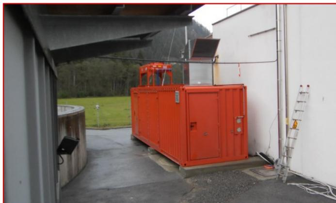
Ein Meilenstein in der effizienten Energienutzung wurde dieses Jahr mit dem Einbau eines Blockheizkraftwerkes bei unserer Verbandskläranlage gesetzt. So kann nun seit Oktober 2012 ca. die Hälfte der notwendigen elektrischen Energie für die Abwasserreinigung selbst erzeugt werden.
